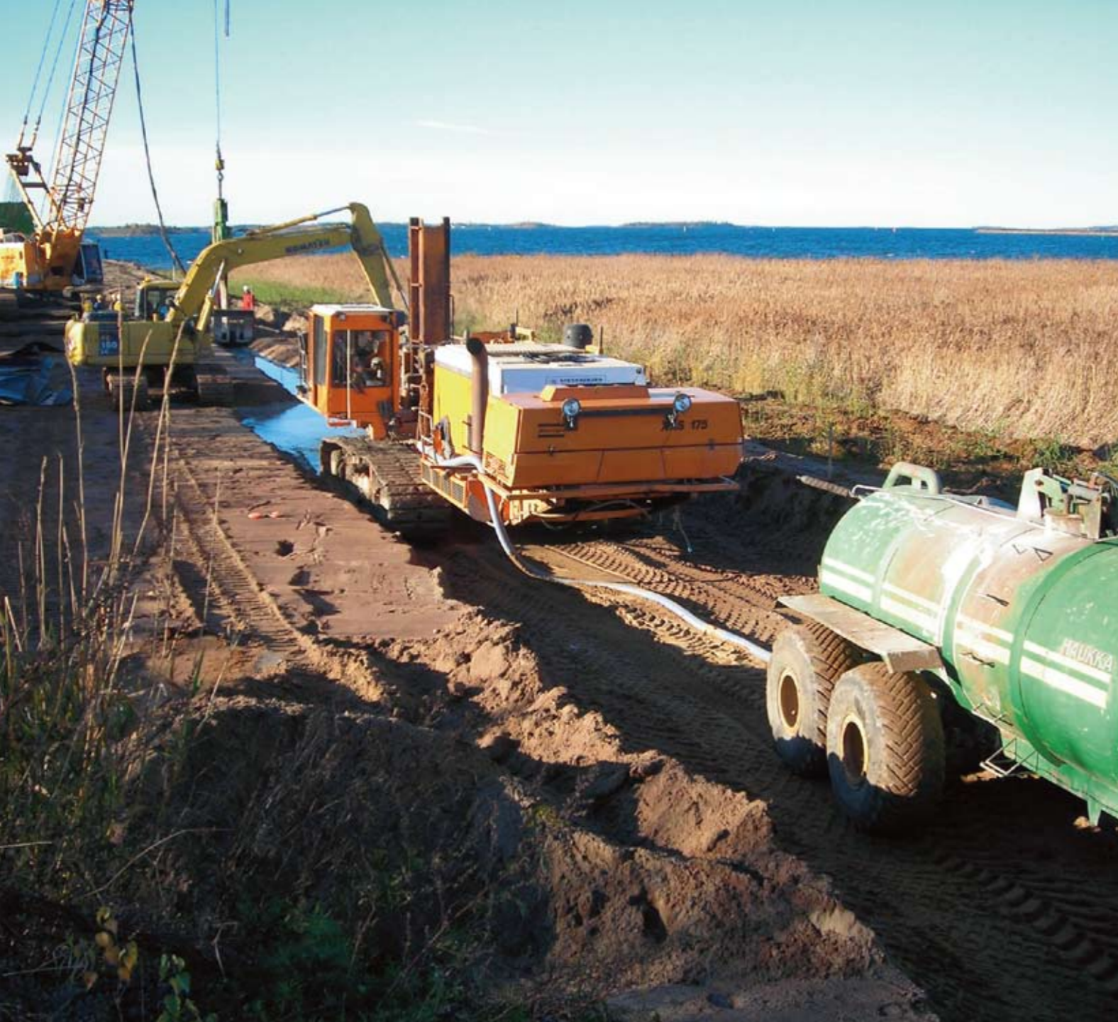
Mise en place d'écrans Geolock à Kokkola, Finlande
